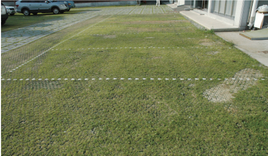
〈그림 25〉 잔디포장의 설치 예(환경부)
